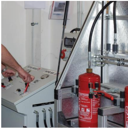
Tartályok nyomáspróbázása (a palástba beütött érték szerint)
